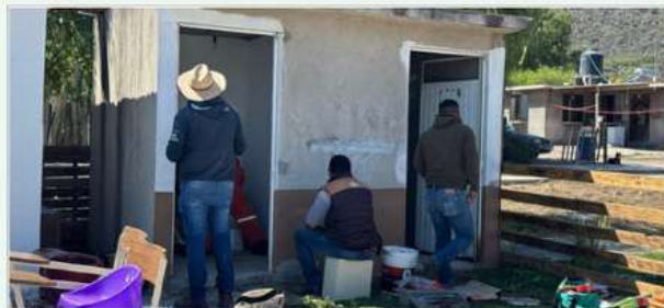
TRABAJOS DE REHABILITACIÓN
