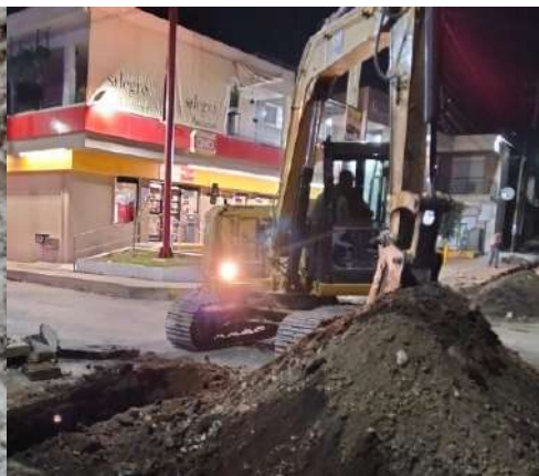
Drenaje Sanitario calle Efigenio Zapata
