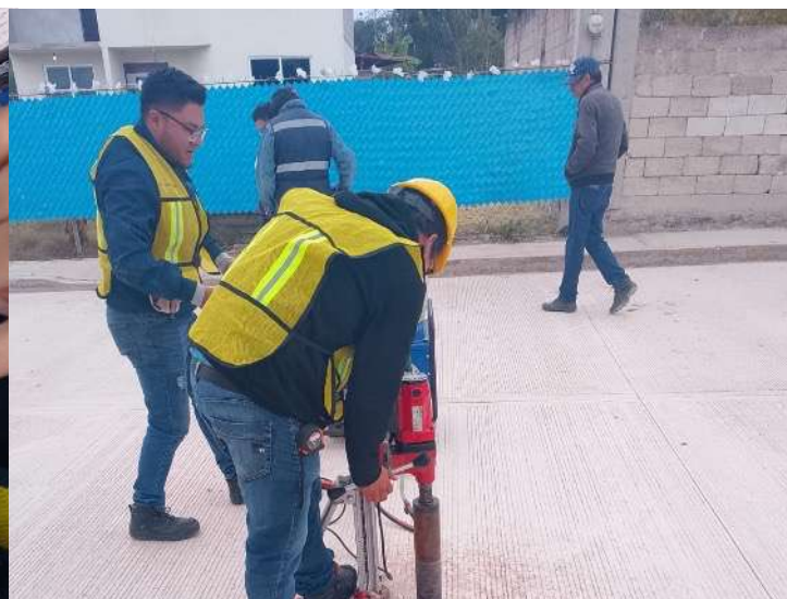
Extracción de Núcleo de concreto por parte del Laboratorio de la Secretaria de Contraloría
