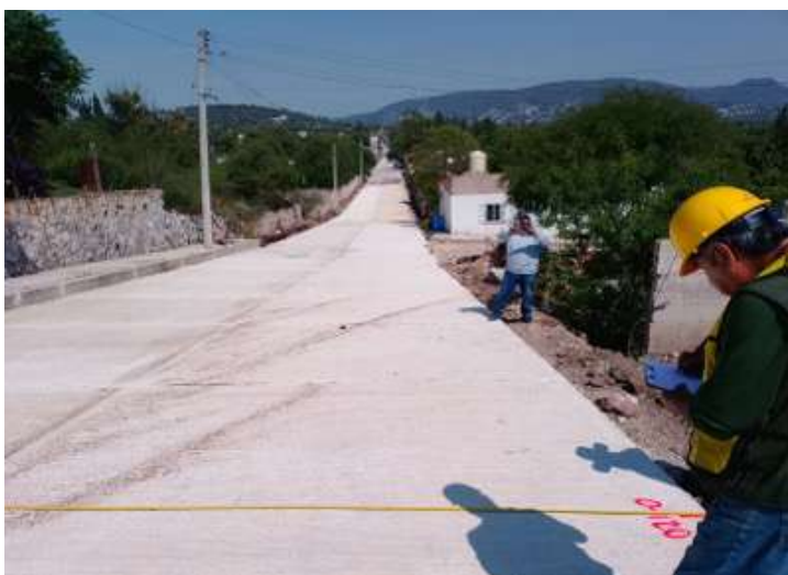
Inspección de trabajos de la Secretaria de Contraloría
