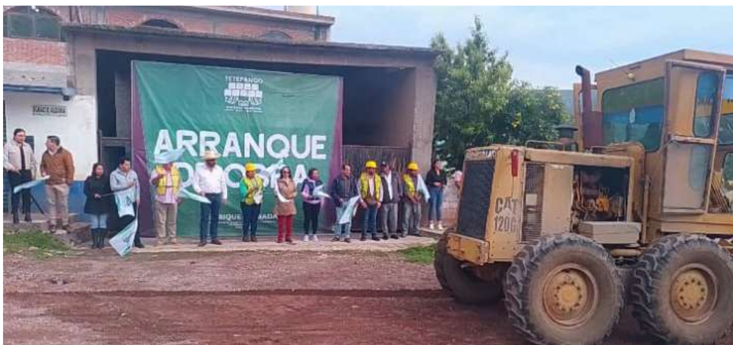
Inicio de Obra Pavimentación calle Ignacio Aldama, Ulapa de Melchor Ocampo
