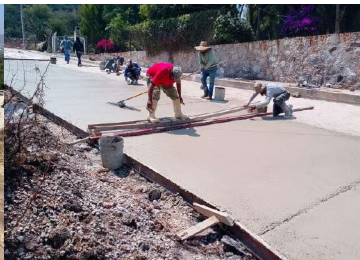
Tendido de concreto hidráulico con malla de acero calle Felipe Ángeles. Col. Rojo Gómez.
