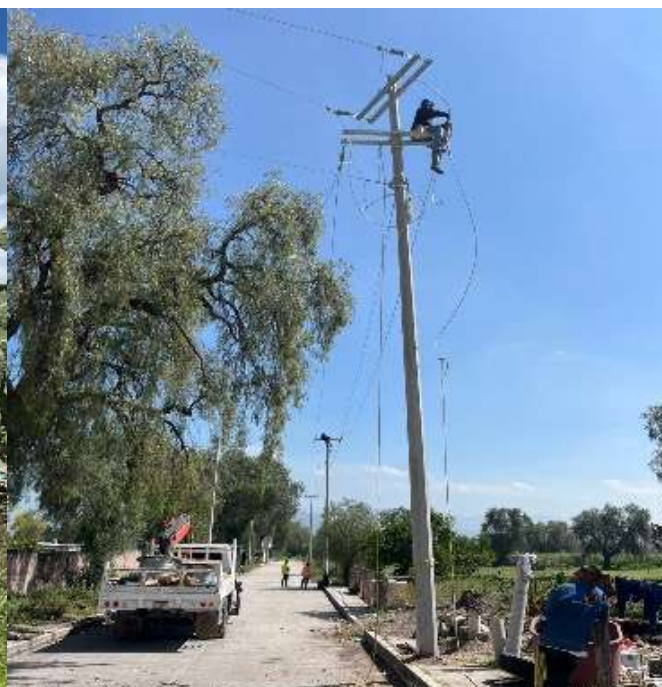
Electrificación Calle 21 de marzo colonia La Hormiga
