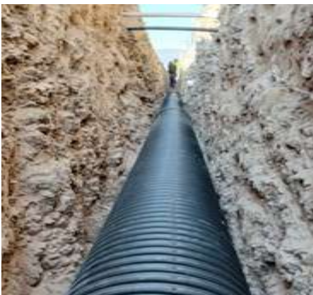
Drenaje Sanitario Av. Aguascalientes
