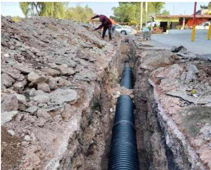
Drenaje Sanitario Calle Efigenio Zapata
