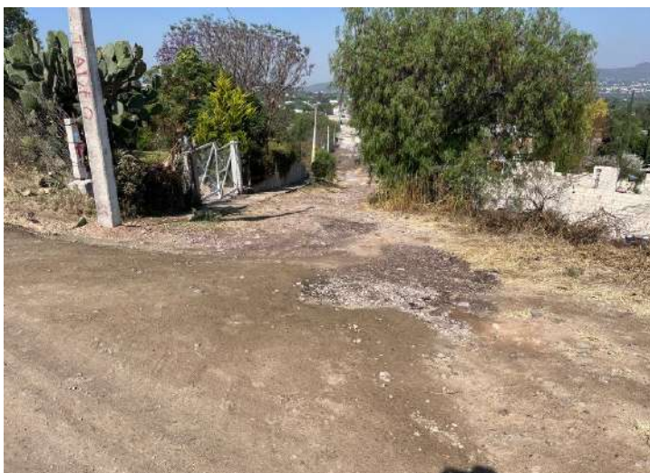
Condiciones iniciales de la calle Felipe Ángeles
