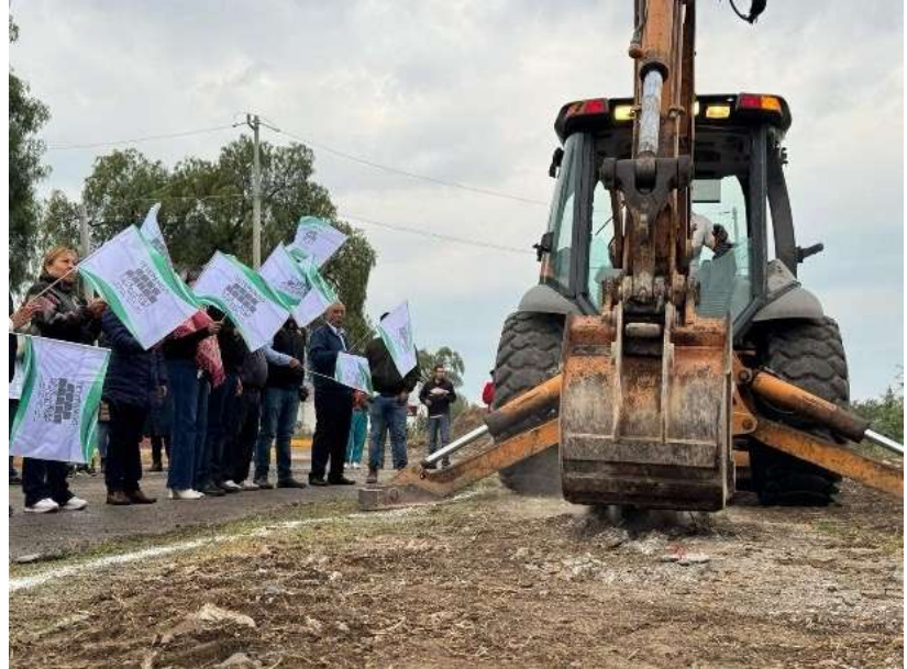
Ampliación de red de agua potable puente los Durmientes.
