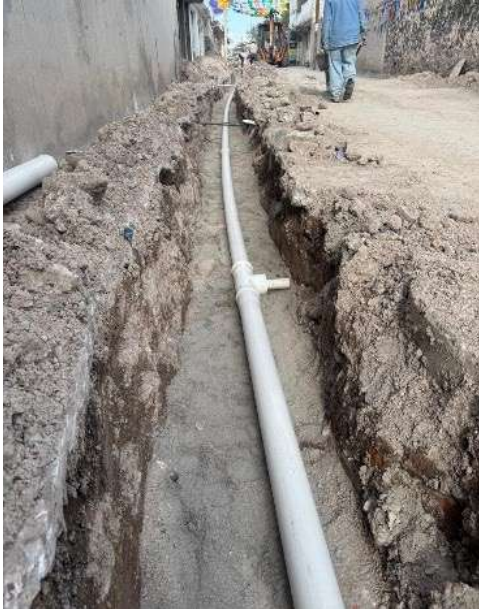
Reposición Tubería en A. Zaragoza
