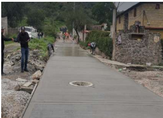
Pavimentación Hidráulica calle Constituyentes, Rojo Gómez
