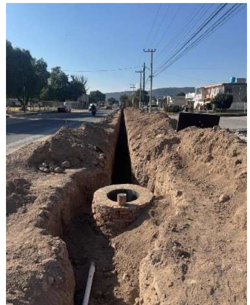
Drenaje Sanitario Av. Aguascalientes
