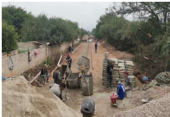
Pavimentación calle Melchor Ocampo, Ulapa
