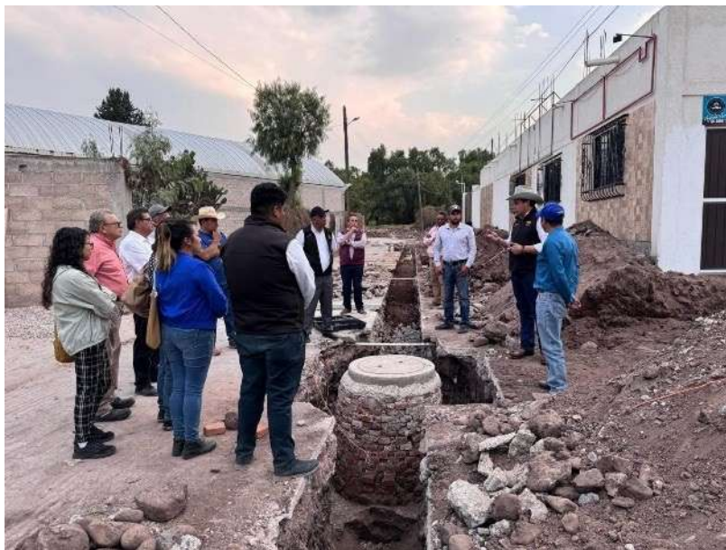
Drenaje Sanitario Calle Brasil
