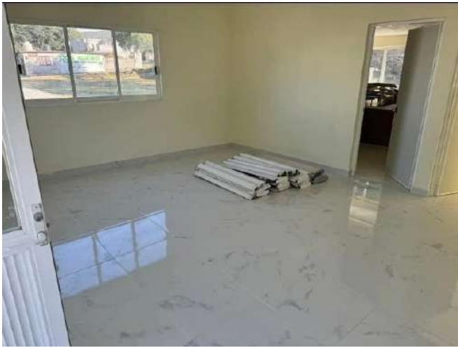
Recibidor rehabilitado de Casa de Salud Cabecera Municipal
